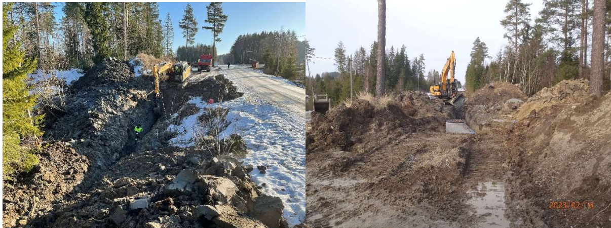
Fra ledningsbytte langs Vigernesveien
